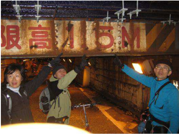
制限高1.5mの線路下通路、低い
