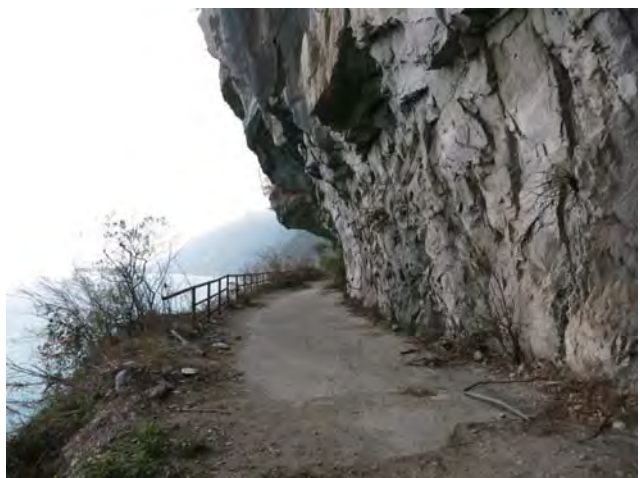
蘇花公路の旧道(廃道)
