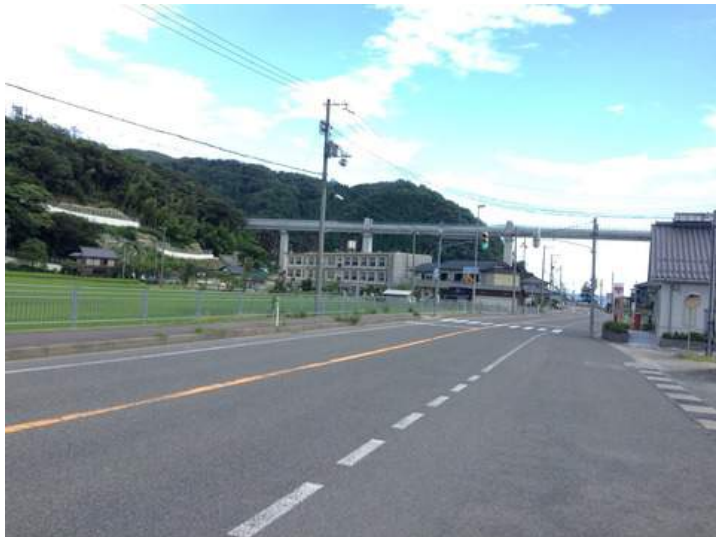
国道178号の上には余部橋梁が。現在はコンクリート製になっています。
